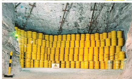
**Abb. 2:** Einlagerung in Schichten von 3 Fässern übereinander, dazwischen eine Salzschiicht von 1 m Grafik (1), Fotos (2): Bundesamt für Strahlenschutz
