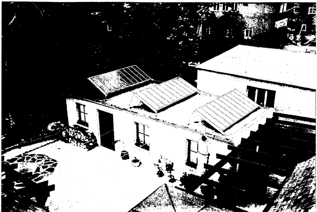
Bild 27: PV-Anlage Herrnhut, 1,59 kW p
