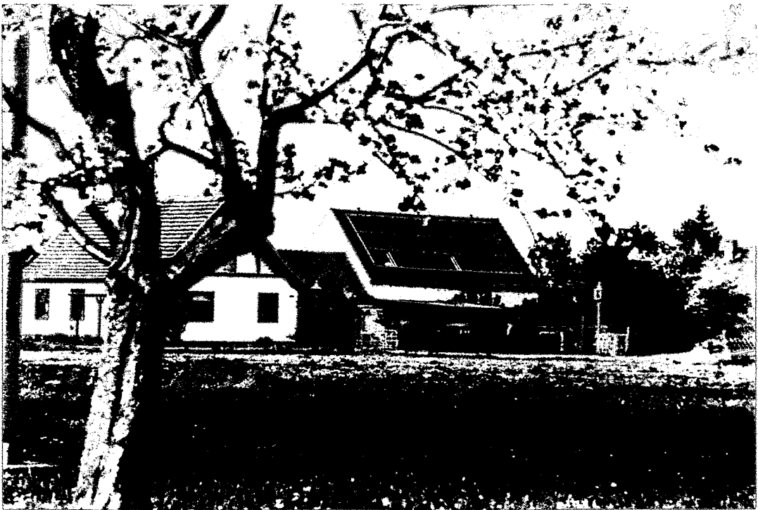
Bild 20: PV-Anlage Horka II, 4,24 kW p
