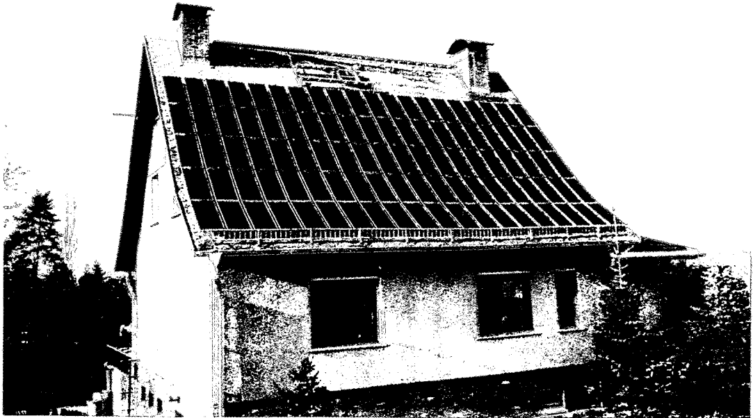
Bild 19: PV-Anlage Reichenberg, 5,0 kW p
