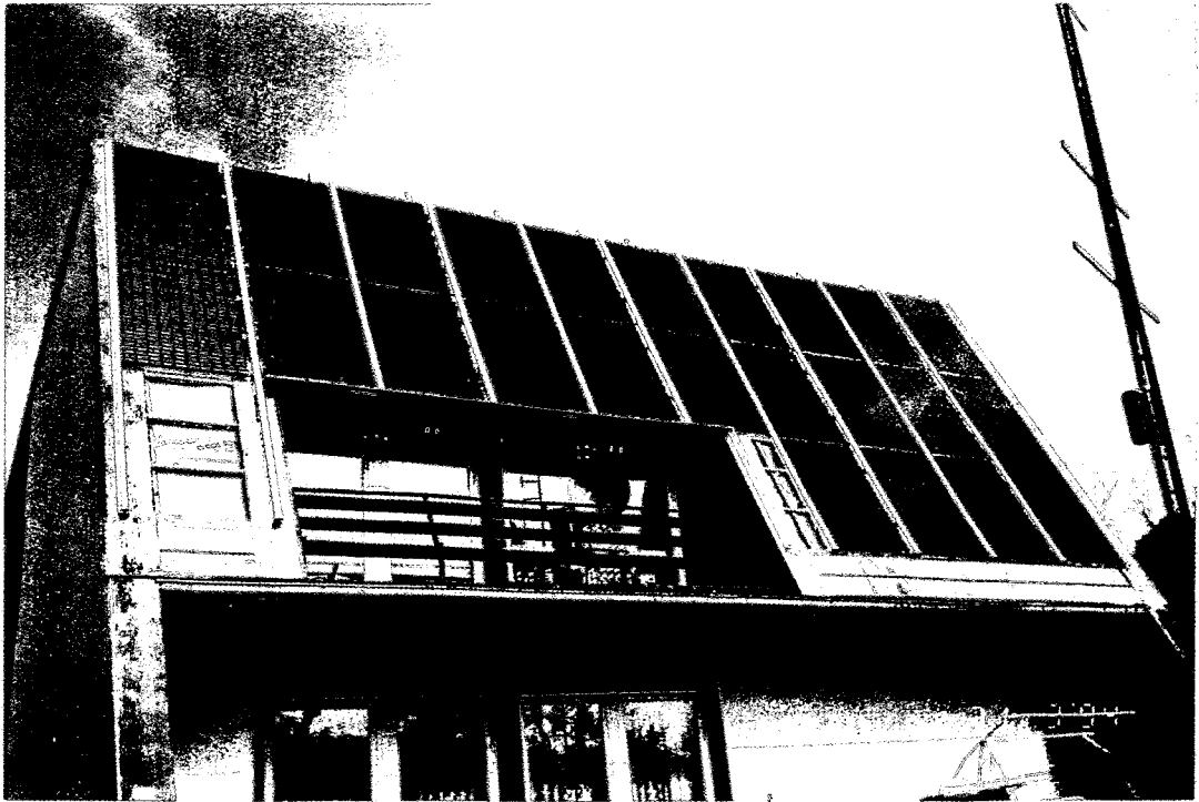
Bild 26: PV-Anlage Dresden VIII, 4,896 kW p
