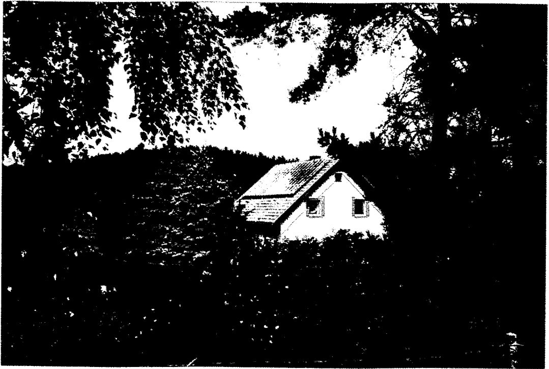
Bild 21: PV-Anlage Oelsnitz, 3,816 kW p
