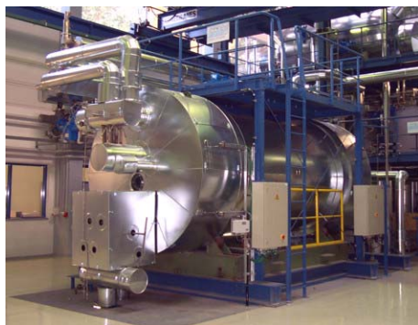
Abb. 2.13 Kondensatorbehälter
