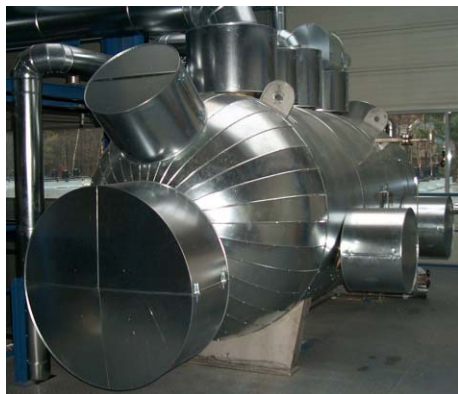
Abb. 2.11 Dampftrommel
