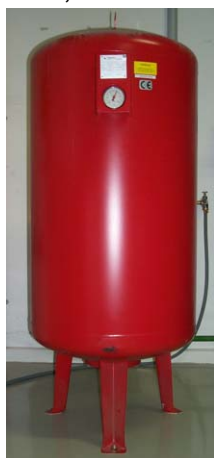
Abb. 2.18 Druckausgleichsbehälter
