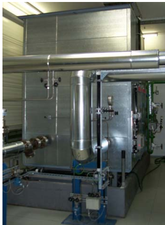
Abb. 2.2 Elektrokessel
