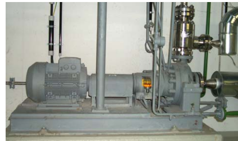
Abb. 2.14 Kondensatorpumpe
