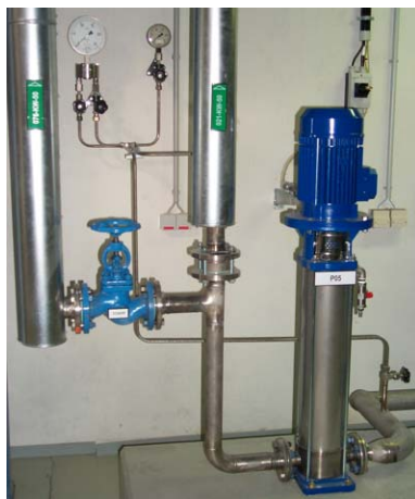
Abb. 2.15 Auffüllpumpe
