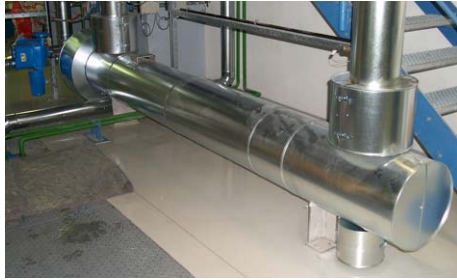
Abb. 2.4 Wärmetauscher W01
