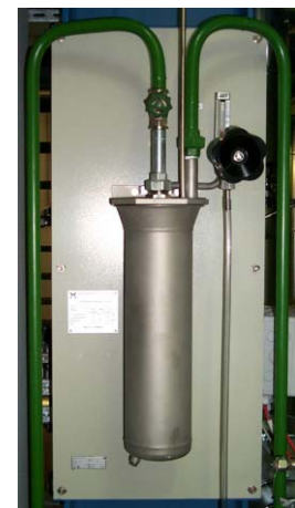
Abb. 2.7 Probenahmekühler
