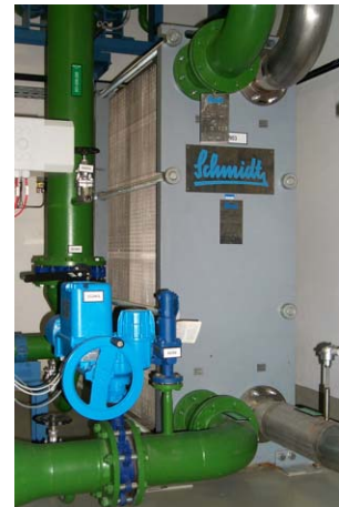
Abb. 2.17 Plattenwärmetauscher
