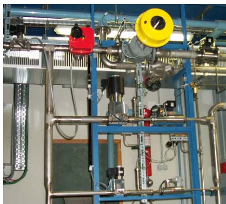
Abb. 2.20 Druckluftregelstation
