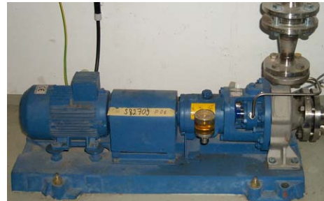
Abb. 2.16 Entleerungspumpe
