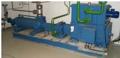
Abb. 2.6 Kesselspeisepumpe
