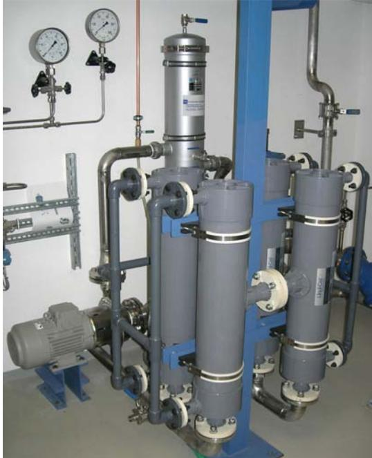
Abb. 2.2 Speisewasserentgasungsmodul der Versuchsanlage TOPFLOW
