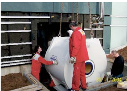
Abb. 2: Anlieferung des ca. 5 t schweren Magnetresonanztomographen für kleine Versuchstiere
