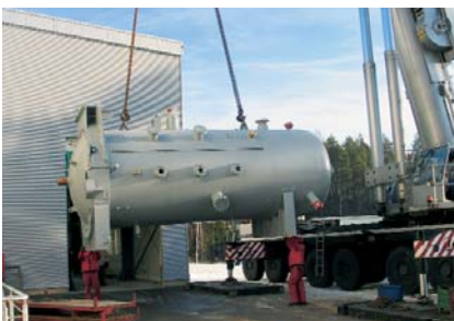
Abb. 3: Anlieferung des Druckbehälters für den neuen Heißstrangversuch an der TOPFLOW-Versuchsanlage
