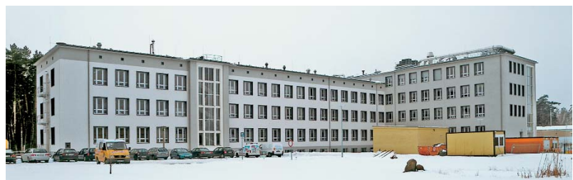
Abb. 1: Außenfassade des Gebäudes 8a nach der Sanierung
